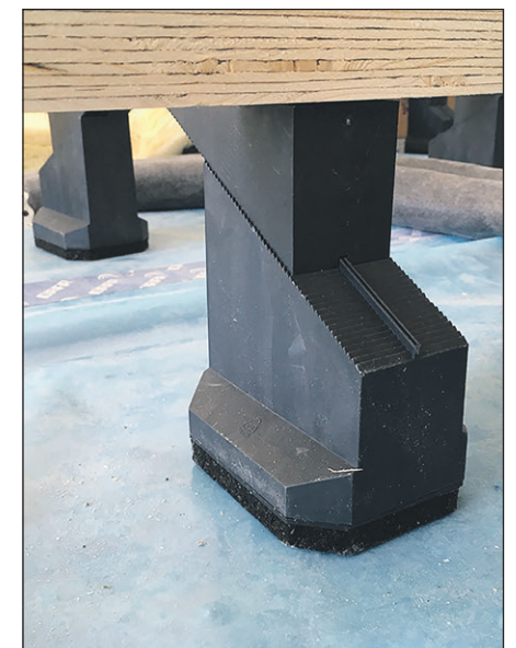
For etageboliger med beton- eller tegldæk kan det være en god ide at klodse trægulvet op på strøer med plastkiler på lyd-dæmpende puder.
